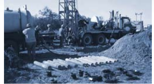
Instalación del EnviroAnode® en una Refinería
