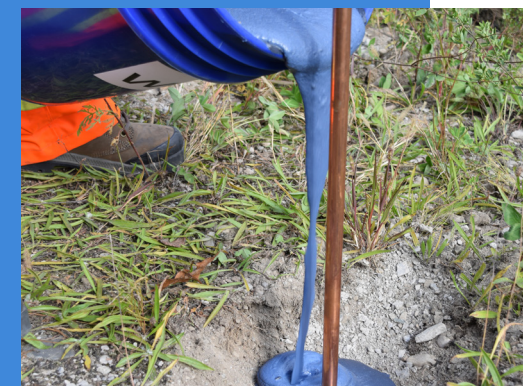
POUR / TROWEL INTO PLACE
